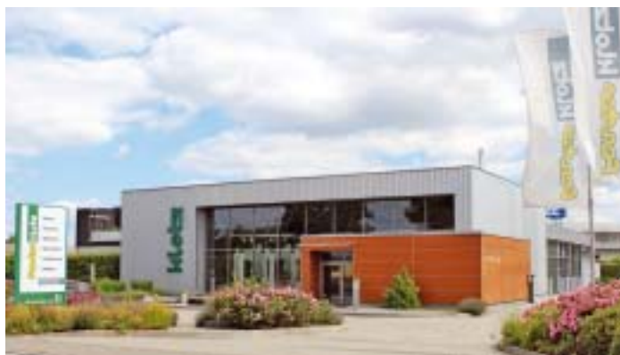
/ Einladend: Das moderne Firmengebäude am Stadtrand von Worms. An einem zweiten Standort betreibt der Tischlerbetrieb weiterhin ein Bestattungsinstitut.
